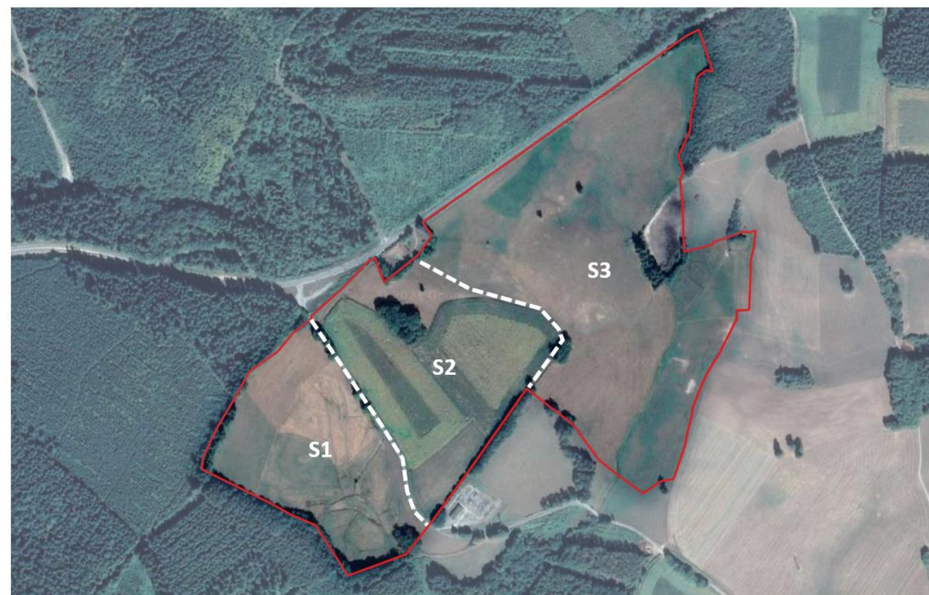
Figure 193 : Cartographie dévoilant le découpage interne en trois parties du site d'étude (Crédit photo : NCA Environnement)
