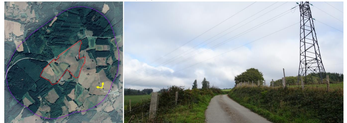
Figure 191 : Photographie illustrant un pylône électrique raccordé au poste source situé en contrebas (Crédit photo : NCA Environnement)
