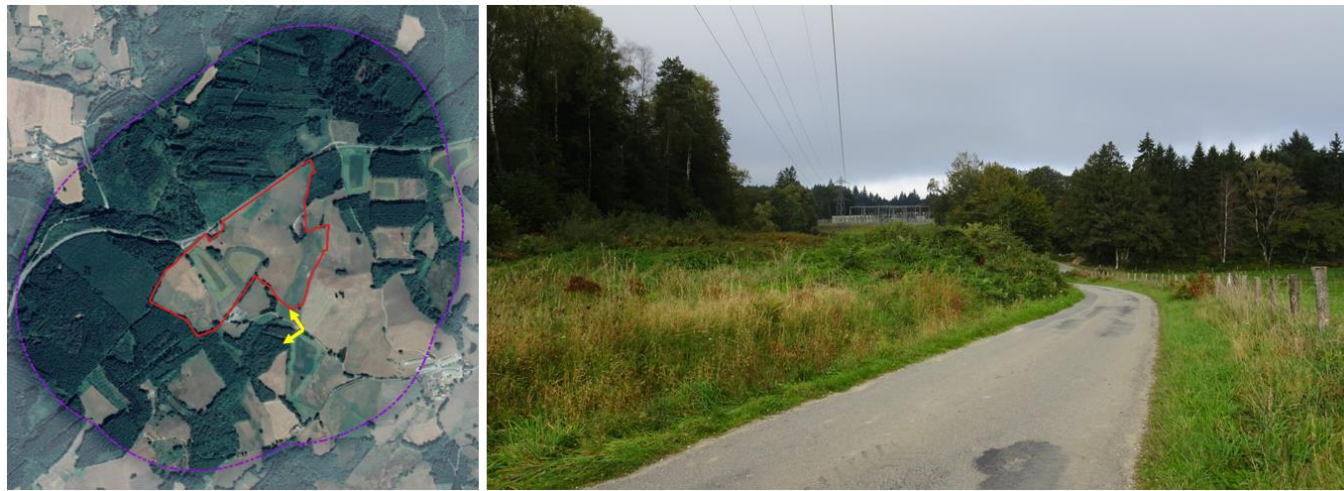
Figure 188 : Photographie illustrant la voie communale traversant l'AEI et connectant la RD 941 et la RD 36 (Crédit photo : NCA Environnement)
